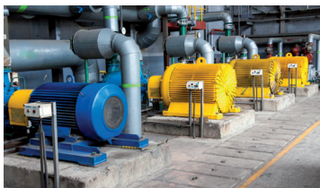
Plantas / Instalación de equipos
