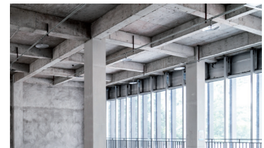
Structures en béton
